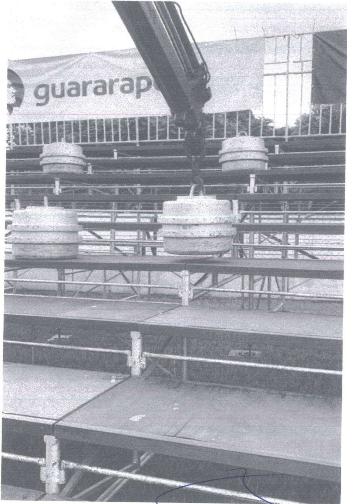
Peso de 500 kg, colocado em cima da estrutura
