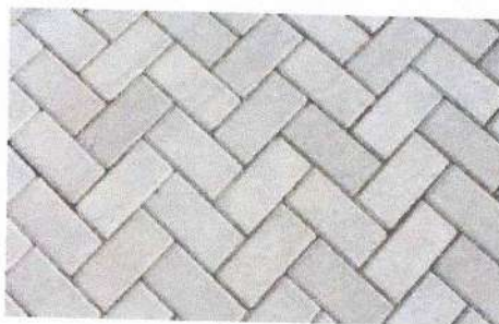
Figura 04- Paver locado no estilo escama de peixe
