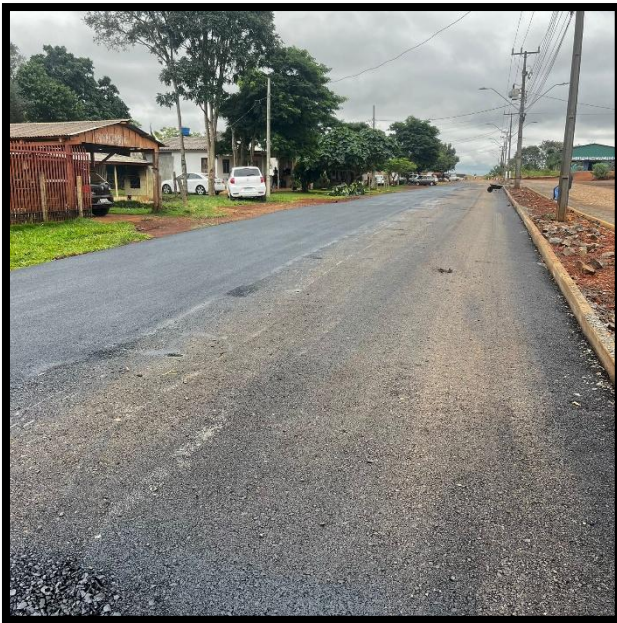
Foto 1 – Avenida Principal – Capa - Trecho 4
