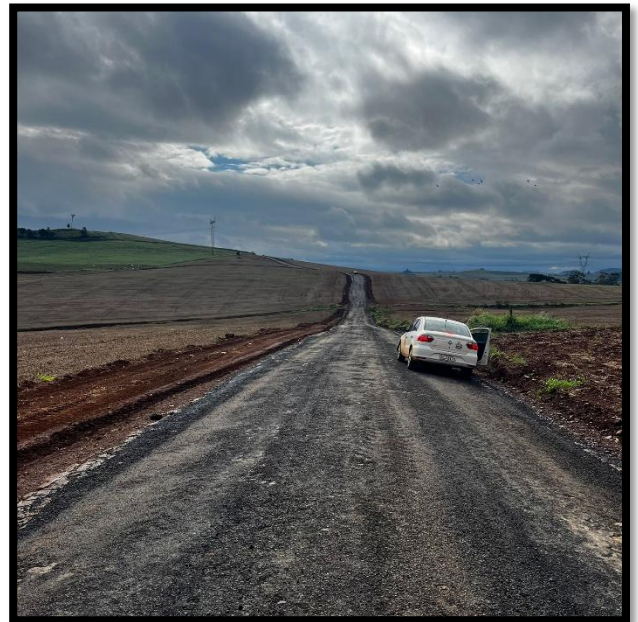
Foto 2 – Reperfilamento - Trecho 2
