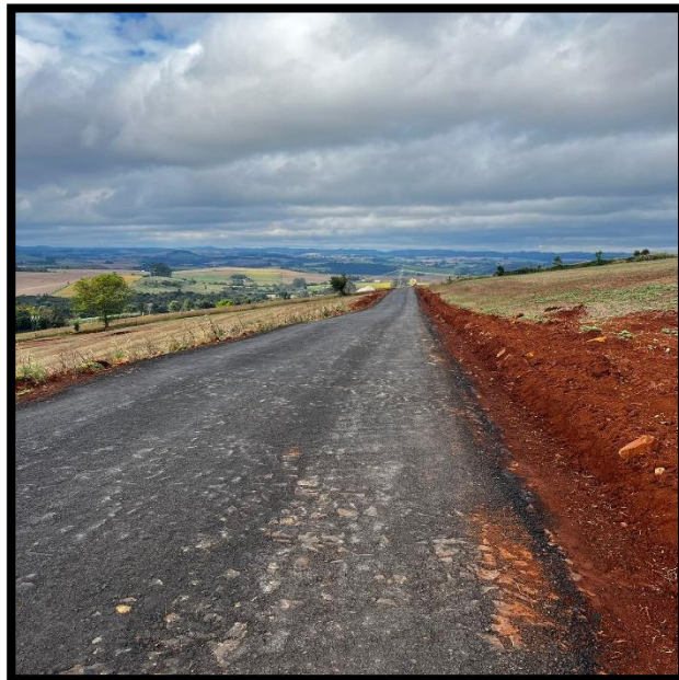
Foto 4 – Reperfilamento – Trecho 2 e 3
