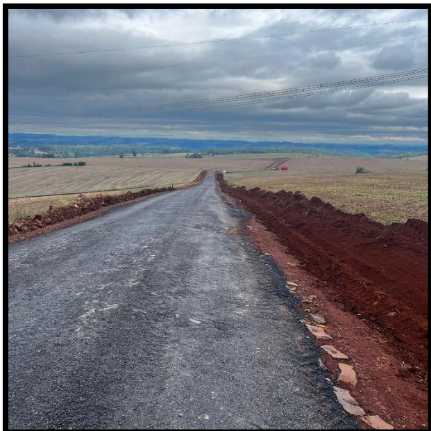
Foto 5 – Reperfilamento – Trecho 2
