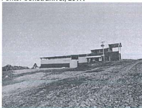
Figura 3.23: Instalações do aterro em operação. Fonte: Construnível, 2017.
