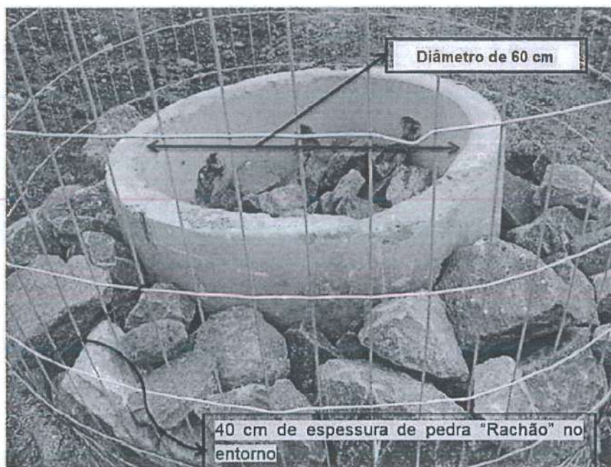
Figura 3.1: Drenos de Gases.
