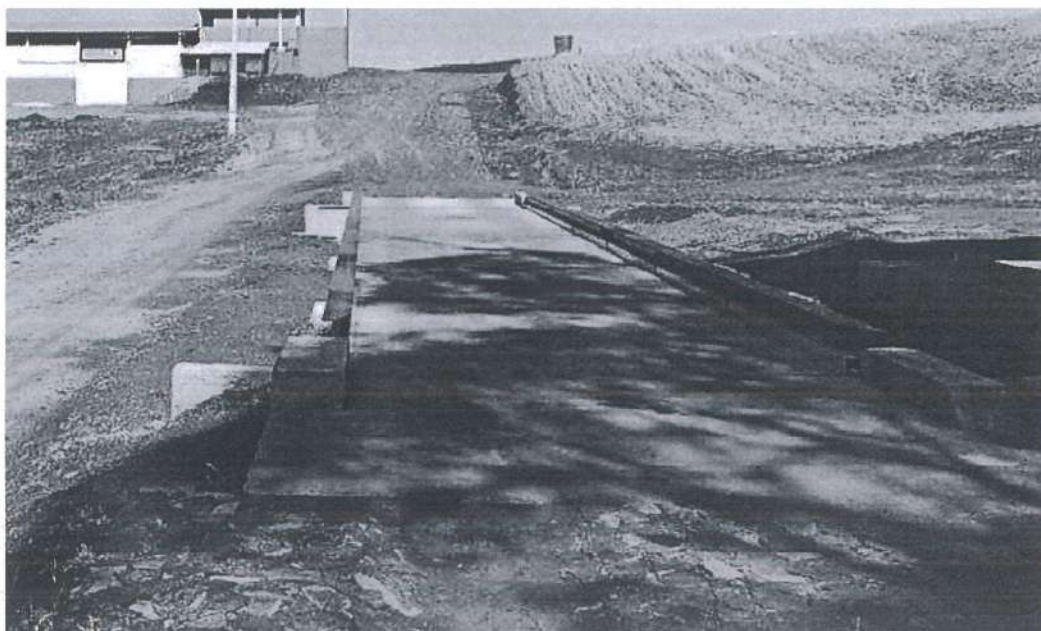
Figura 3.6: Balança Rodoviária. Fonte: Pijack Engenharia, 2017.
