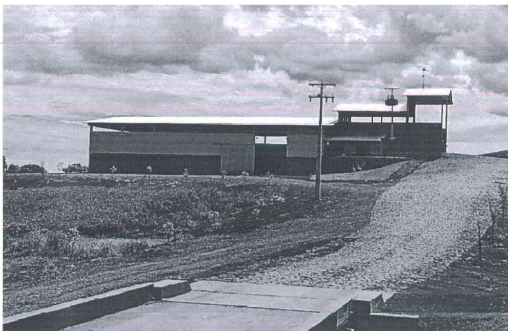
Figura 3.7: Barracão de Triagem, Armazenamento, Prensagem e Enfardamento de Resíduos. Fonte: Pijack Engenharia, 2017.
