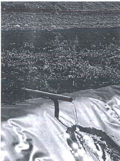
Figura 3.16: Aparência do chorume/lixiviado após passar pela Estação de Efluentes Líquidos Industriais Avançado por Eletrofloculação, Eletrooxidação e Filtros especiais. Fonte: Pijack Engenharia, 2017.
