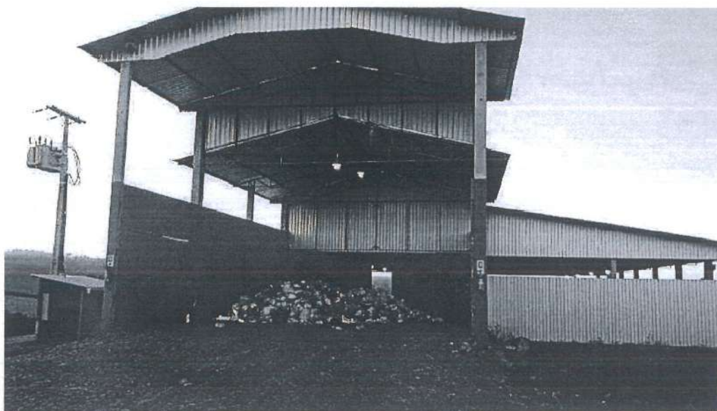
Figura 3.8: Moega de Recepção de Resíduos (Barracão de Triagem, Prensagem e Enfardamento).
