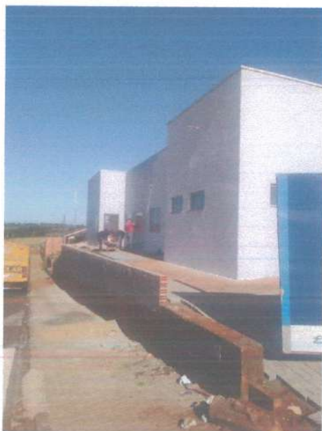
MUROS E CHAPISCO
