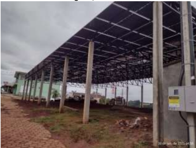
Foto 04 – Garagem / Cobertura– Área externa
