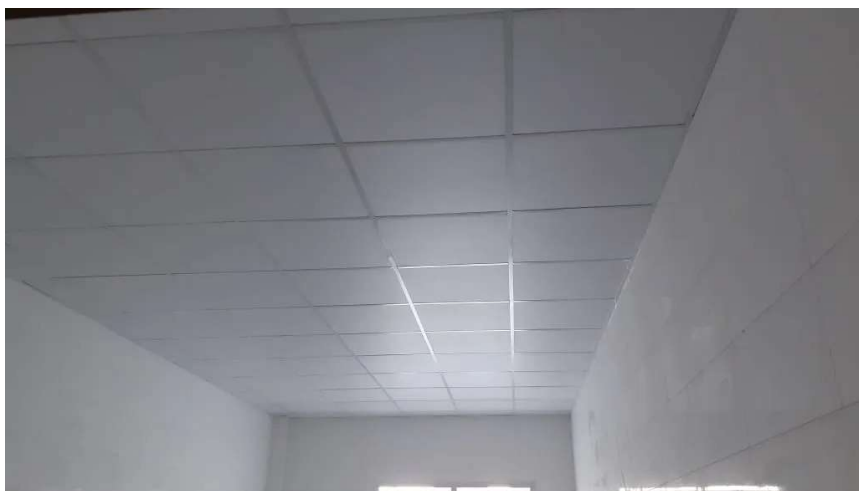
Figura 30 – Forro modular removível em gesso com película de PVC.
