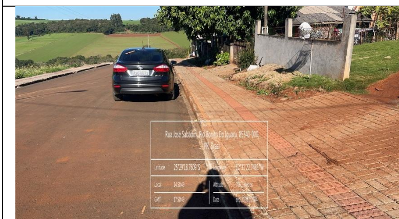
FOTO 2 – MEIO FIO E SARGETA/SERVIÇOS DE URBANIZAÇÃO
