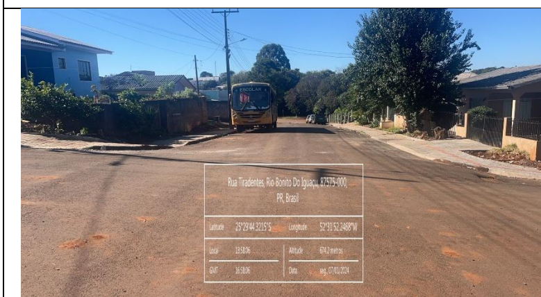
FOTO 2 – MEIO FIO E SARGETA/SERVIÇOS DE URBANIZAÇÃO
