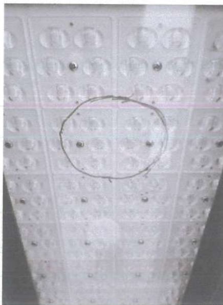
Foto 3 - Evidência de conformidade.
