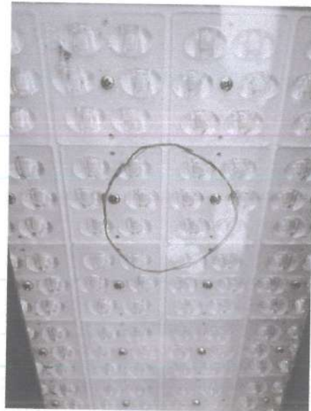
Foto 3 - Evidência de conformidade.
